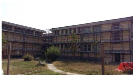
interventi di riqualificazione esterna con la realizzazione di un cappotto, per ottimizzare l'isolamento termico della struttura, e la relativa tinteggiatura con tinte più vivaci. A questo si aggiungerà il trattamento e la tinteggiatura di tutte le parti in cemento armato a vista come opera complementare.
